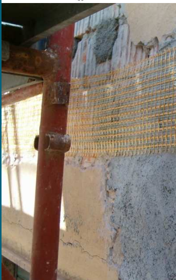
Fascio di fibre di PBO su mata rivolgate sul fronte est e ovest. Successiva rasatura, ripristino intonaco e riintegro facciata
